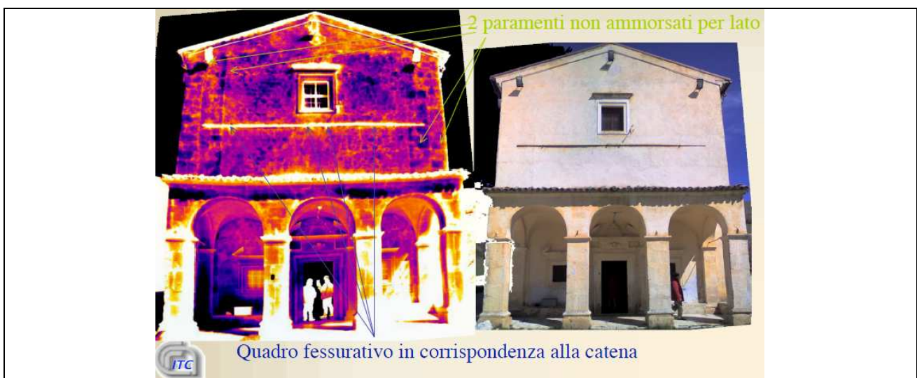
Fig. 2.3.1 Visualizzazione della struttura in esame sulla termocamera.
